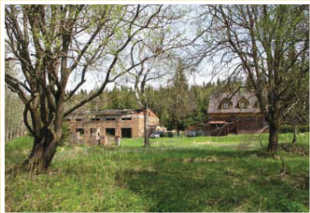
Umkleidegebäude für die Bergleute im Lager Rovnost (Einigkeit).
